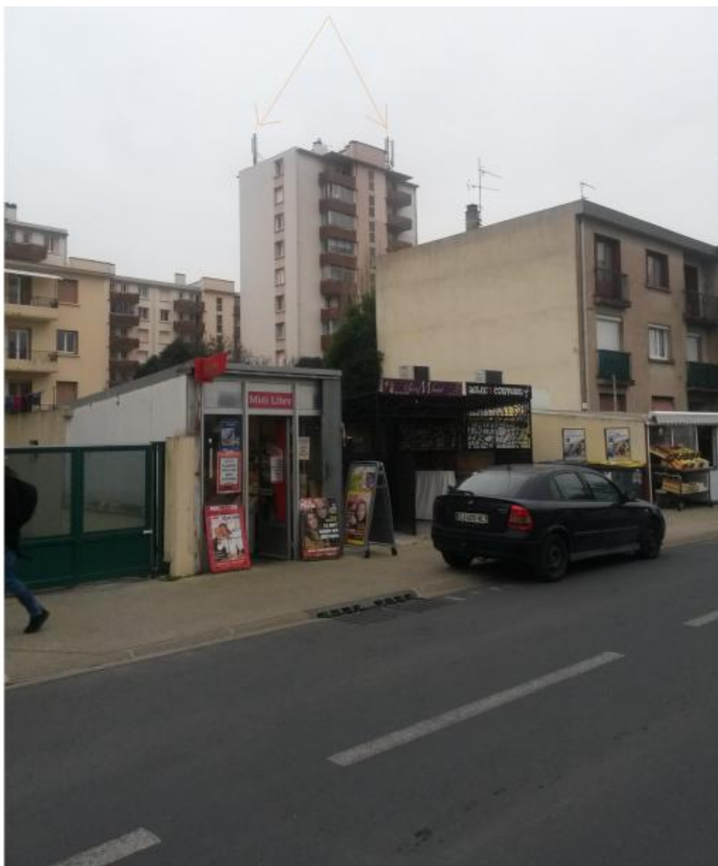
vue 1 : Photo du site existant depuis l'avenue Saint Maur. Pas de modification de l'aspect extérieur
