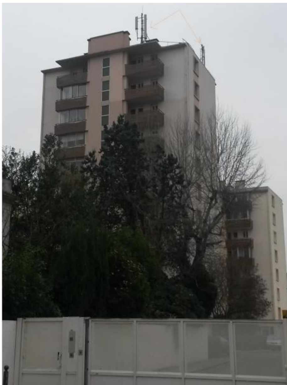
vue 2 : Vue de près. Pas de modification visuelle. Pas de modification de l'aspect extérieur
