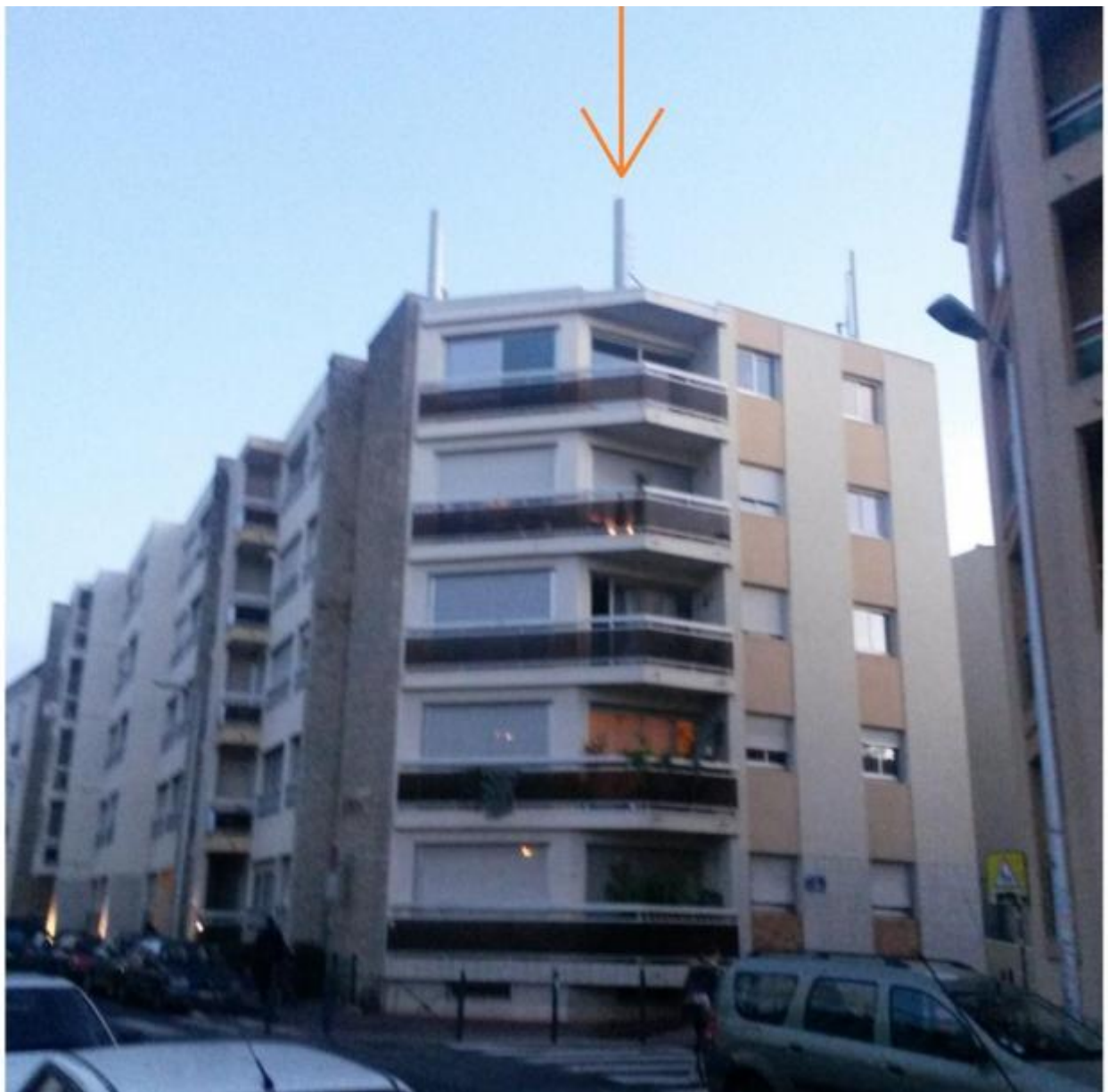
vue 2 : Vue de près. Pas de modification visuelle après le changement des antennes.
